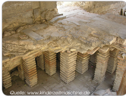
„Schema einer Hypokaustum-Heizung in Arles (Südfrankreich)“
